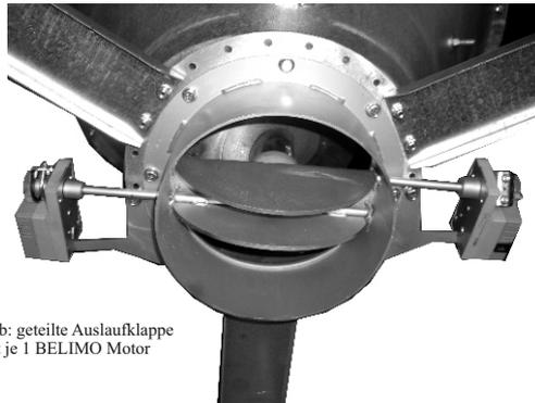
Abb: geteilte Auslaufklappe mit je 1 BELIMO Motor
