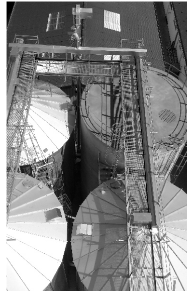
Abb. Siloanlage von oben
