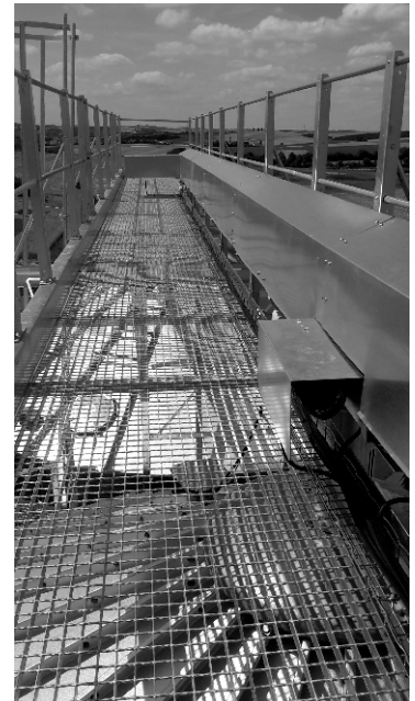
Abb. Laufsteg feuerverzinkt, mit Silofüllredler
