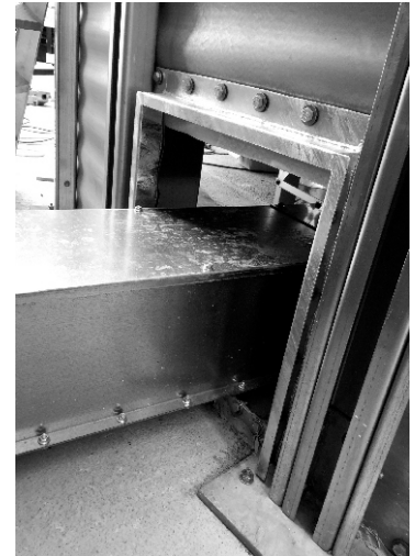
Abb. Silodurchführung für Entnahmeredler
